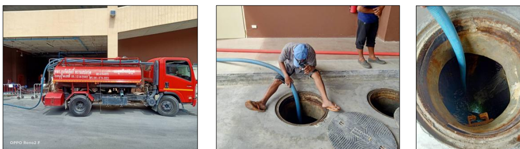
รูปที่ 3-25 สุกตะกอนบ่อบำบัดน้ำเสีย
