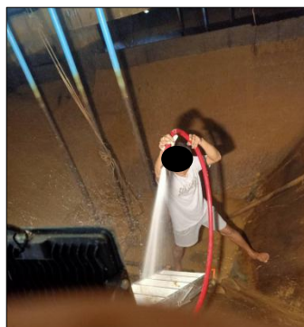
รูปที่ 3-22 ทำความสะอาดถังน้ำใช้
