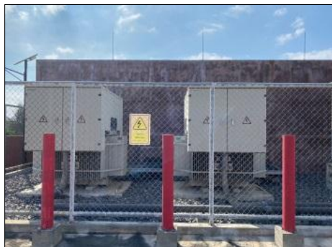
รูปที่ 3-51 หม้อแปลงไฟฟ้า และ แผงกั้นที่ทำด้วยวัสดุทนไฟล้อมรอบหม้อแปลงไฟฟ้า
